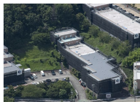
マンション大規模修繕 セーリオ宝塚 大規模修繕
