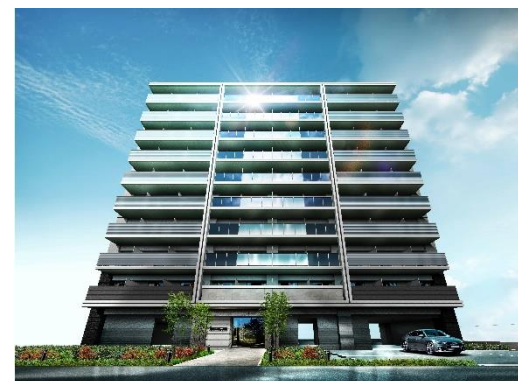
エスリード弁天町ルシェンテ
