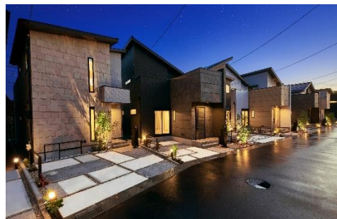
エスリードハウス八幡石清水
