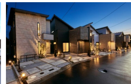
エスリードハウス八幡石清水
