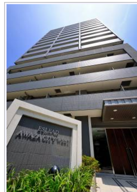
エスリード阿波座シティウエスト 2010年5月竣工引渡 地上15階 総戸数：84戸
