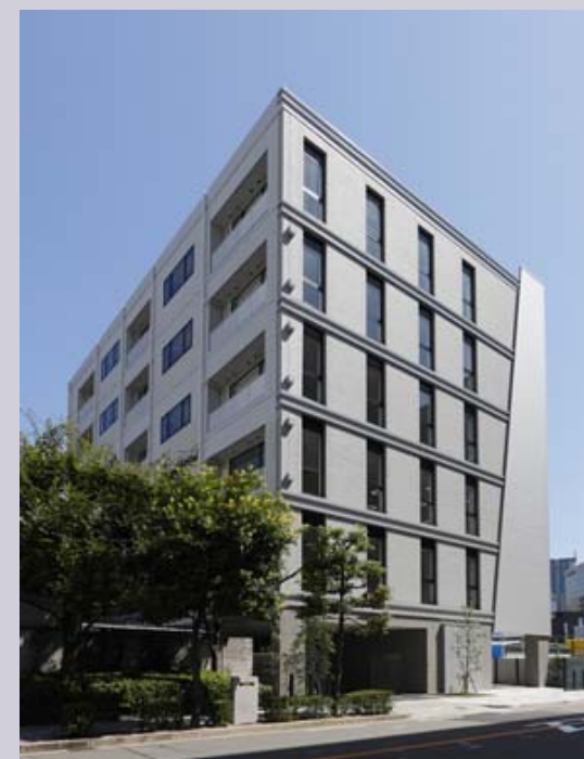
日本エスリード本社 新社屋(平成21年8月竣工)
