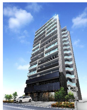
Esリード大阪STATION
